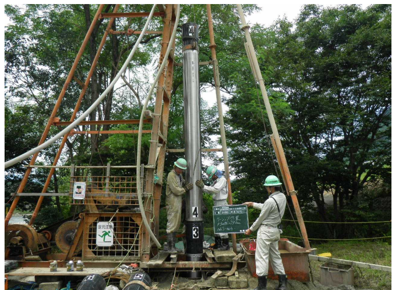
写真2 ストレーナ設置作業状況
