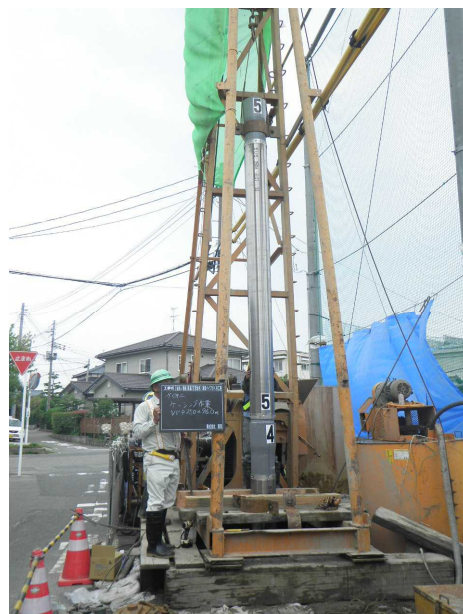
写真2 ストレーナ設置作業状況
