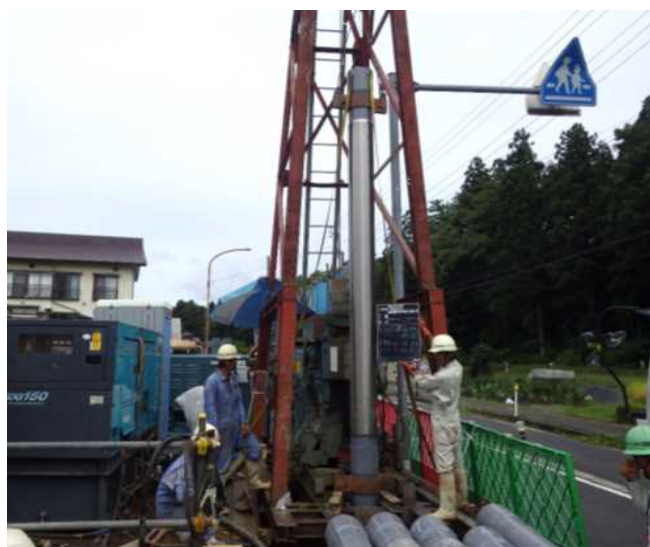
写真2 ストレナー設置作業状況
