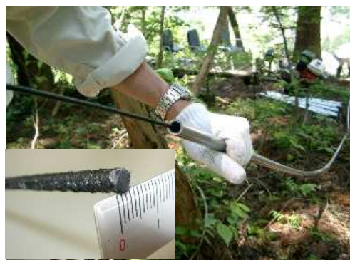
炭素繊維ケーブル設置状況
