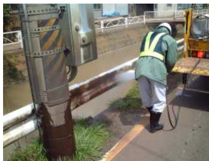
③重曹洗浄液による洗浄
