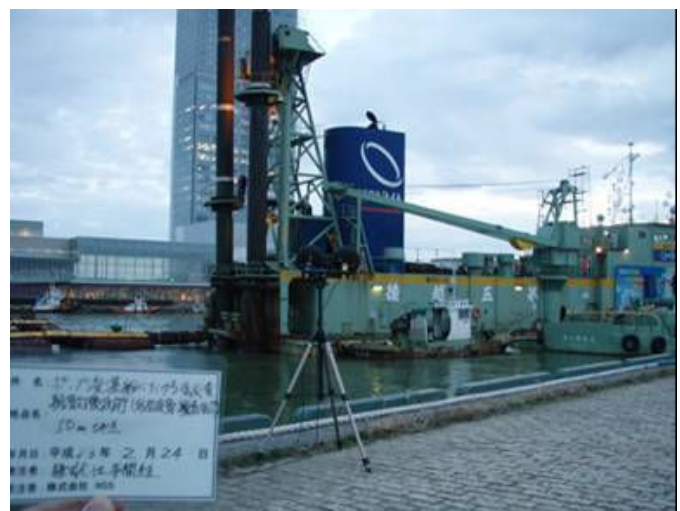
低周波音計測状況(50m地点)
