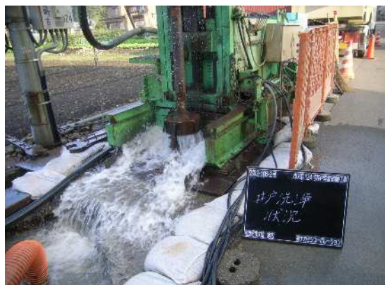
井戸仕上げ状況
