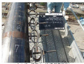
エネルギー緩衝リング(重錘落下後)
