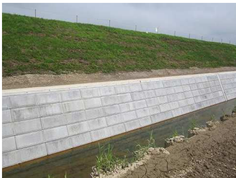
(写真-3.施工完了状況)
