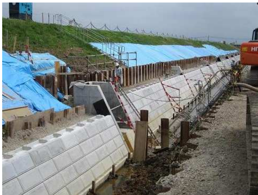
(写真-2.施工状況)
