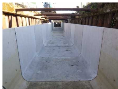
工事完了 (52m)
