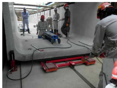
狭小現場作業用「手延べ桁」による位置調整→
