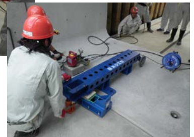
狭小現場作業用「手延べ桁」による位置調整→
