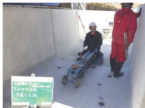
「手延べ桁」による位置調整
