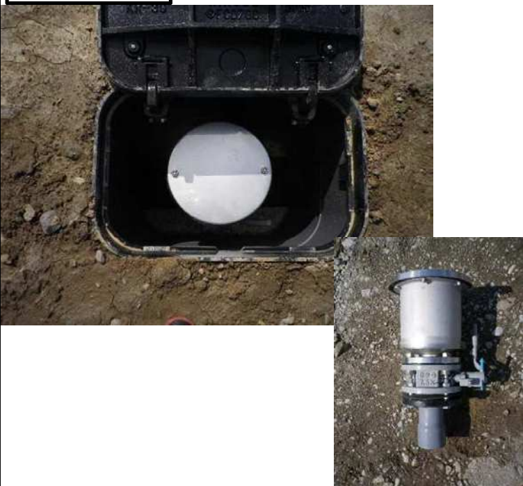
空気弁設置状況
