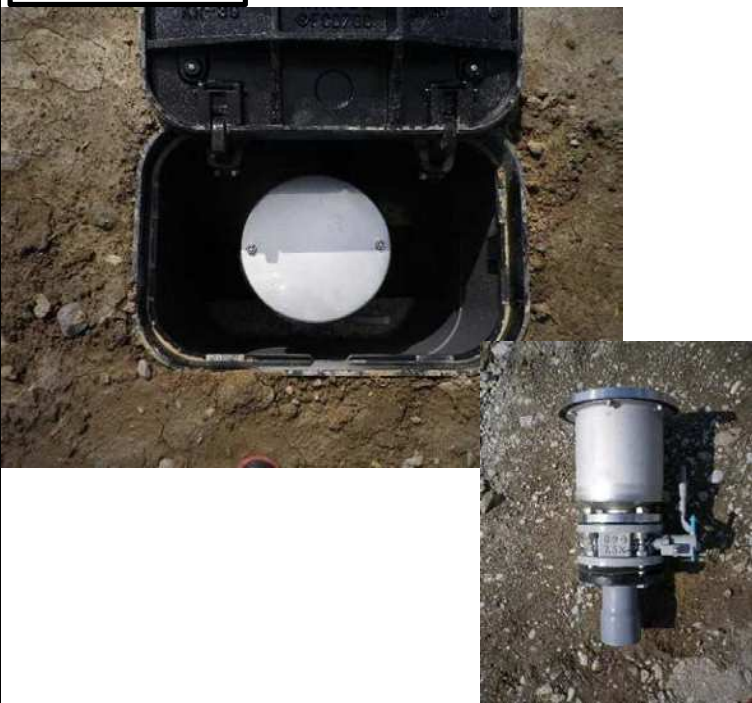
空気弁設置状況
