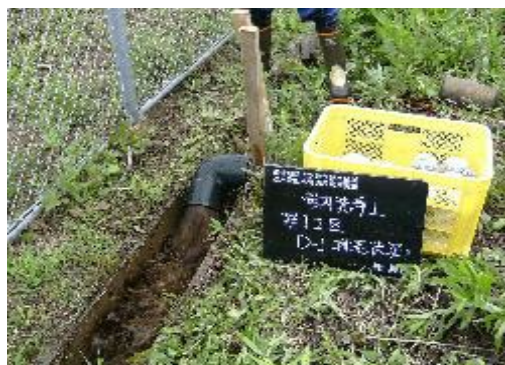
洗浄状況(排水確認1回目)
