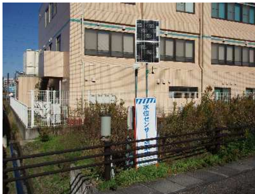
上流側機器設置状況 無線機、太陽電池、機器収納箱
