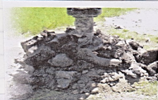
図③ オーガーを左回 転させ、水平方向 に圧密し、静止土 圧する。
