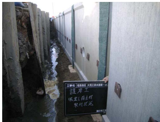
取付状況②
