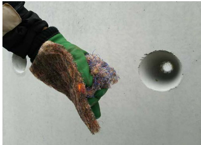
取付状況①
