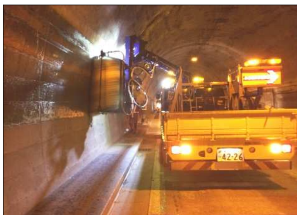
施工状況 トンネル壁面洗浄
