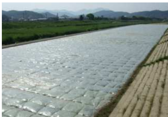
⑤有孔ポリシートによる養生
