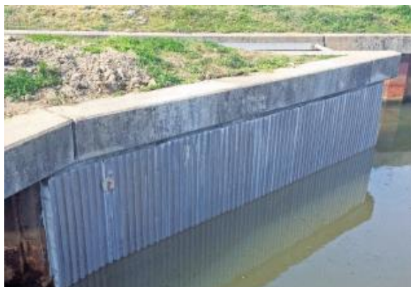
完成写真(平成28年3月 試験施工)
