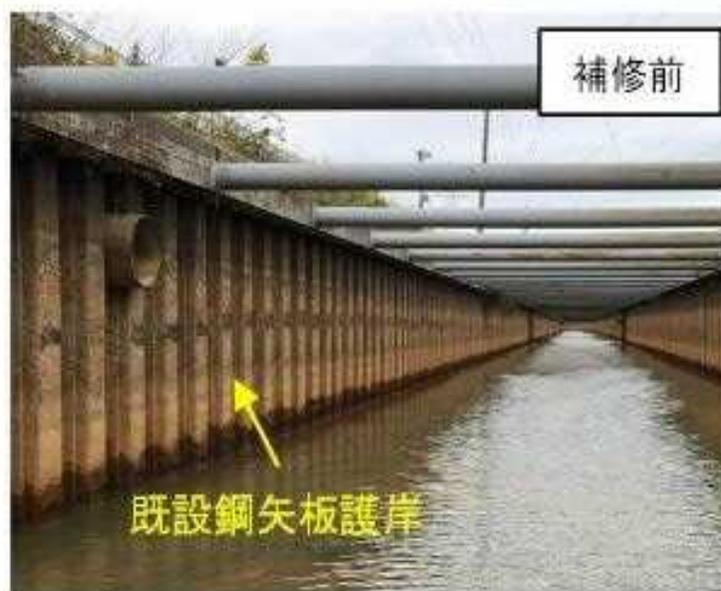
(腐食が進行する既設鋼矢板護岸)
