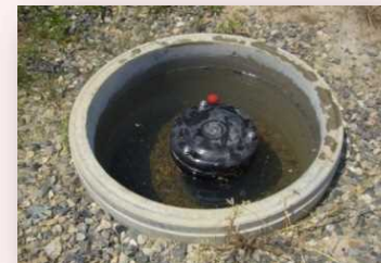
既設品の分解・内部状況
