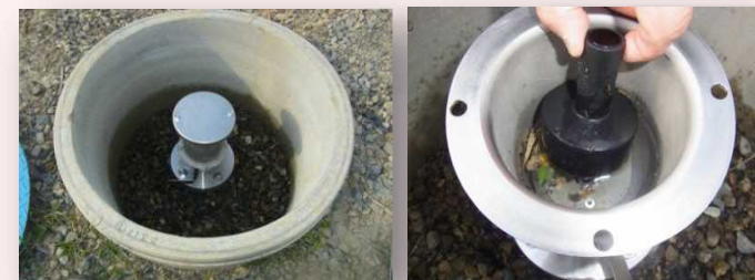
スマートエアバルブへの交換後の経過観察状況
