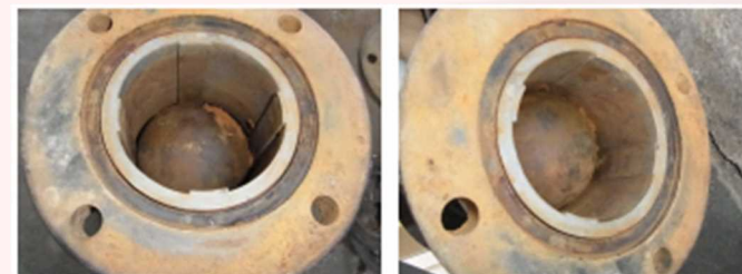
スマートエアバルブへの交換後の経過観察状況
