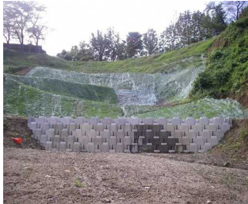
4.完成写真(正面より)
