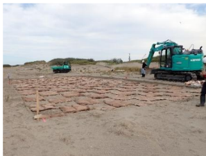
②マット設置
