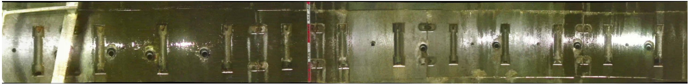
写真 集水ボーリング 回転撮影型カメラによる点検結果
