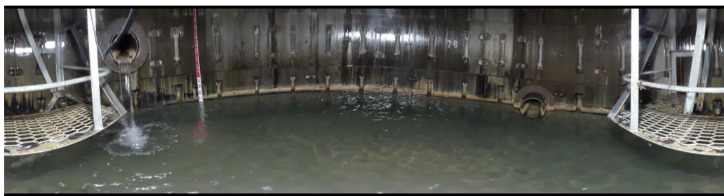
写真 全周撮影型カメラによる点検結果(360° 展開)
